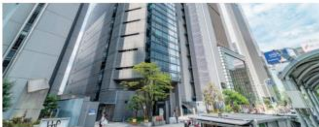
東京建物梅田ビル 外観
