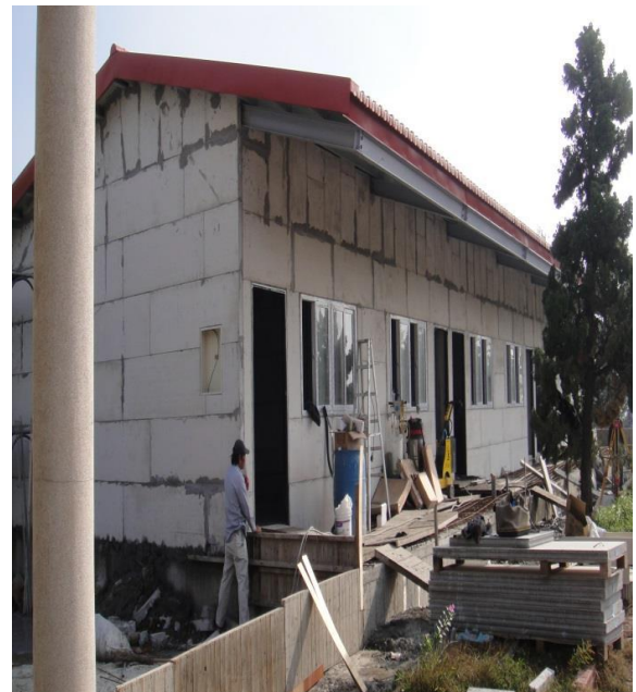
解体後、校舎にはドイツ製隔壁ボード材が使用され、耐震・耐火性が備えられています。（写真左、右）©台湾赤十字組織
