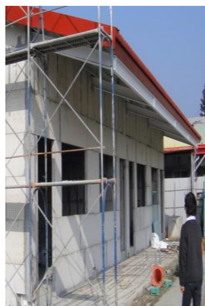
地震により損壊した西棟の教室（写真左）、解体後、再建された建築構造には耐震用に鉄骨構造と隔壁ボード材が使用されています（写真中央、右） ©台湾赤十字組織
