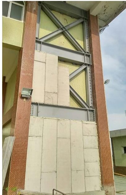
地震により亀裂の入った柱（写真左）。鉄骨と隔壁ボード材により補強された柱（写真中央）。修復後、日赤の支援を示す記念プレートが設置されています（写真右）。©台湾赤十字組織
