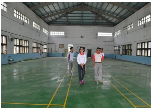
床の改修が完了した屋内テニスコート（嘉義県溪口国民小学校）©台湾赤十字組織
