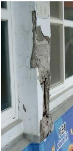
地震により損壊した西棟の教室（写真左）、解体後、再建された建築構造には耐震用に鉄骨構造と隔壁ボード材が使用されています（写真中央、右） ©台湾赤十字組織
