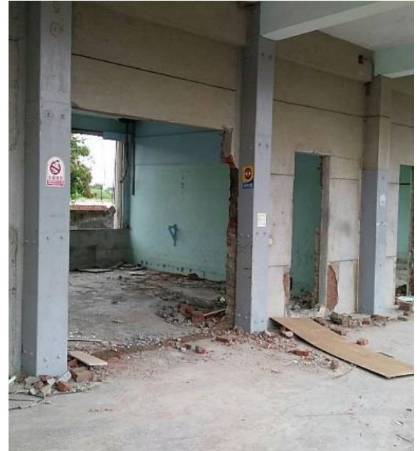
鉄筋にひび割れが生じたため、解体を待つ北棟教室の様子（写真左、右）。©台湾赤十字組織
