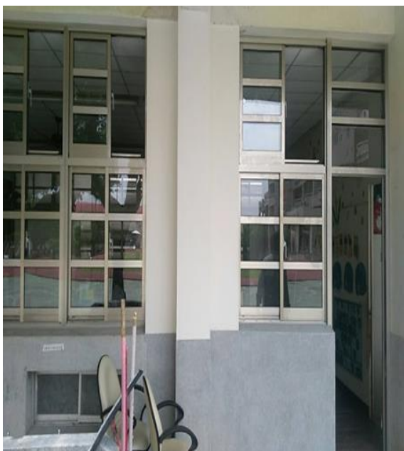
補修後、教室の建築構造の耐震性が向上しました。©台湾赤十字組織
