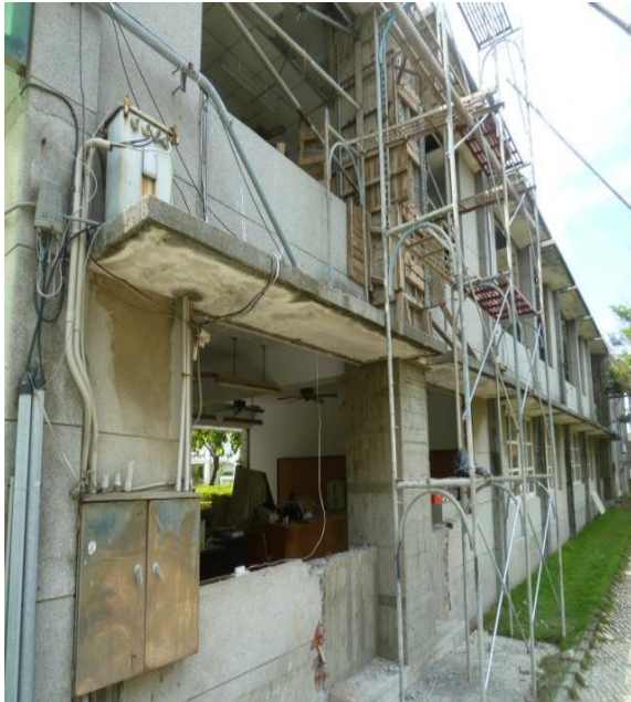
教室の背面にある柱は被覆柱により耐震補強しています。（写真左）窓枠は木製のものから、強化ガラスとプラスチック製窓枠に取り換えています。（写真右）©台湾赤十字組織
