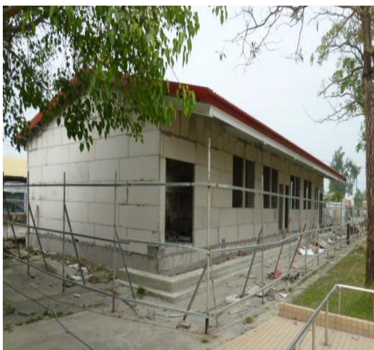
解体後、ドイツ製隔壁ボード材が使用され、生徒や学校スタッフは耐震・耐火性が備えられた美術・工芸教室で学んでいます。©台湾赤十字組織
