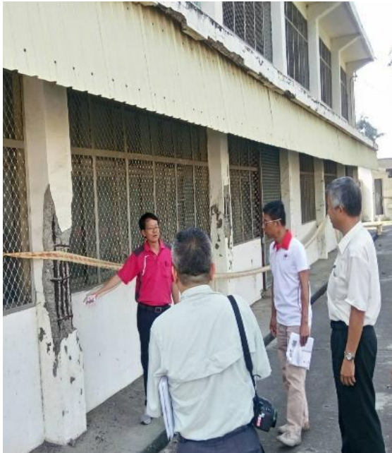
損壊した工芸教室の梁と柱の様子。建築安全調査の結果、解体と再建が必要と報告されました。©台湾赤十字組織
