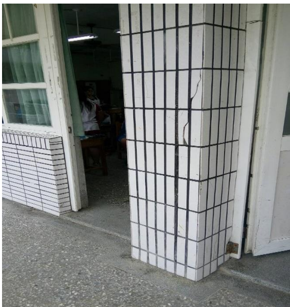
教室の出入り口にある、ひび割れの入った柱（写真左）、被覆柱により耐震補強された柱に日赤からの資金協力を示した記念プレートが設置されています（写真右）©台湾赤十字組織
