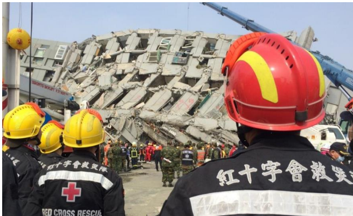
地震により崩壊した Weiguan Jinlong building に救助に駆けつける 台湾赤十字組織のボランティア ©台湾赤十字組織
