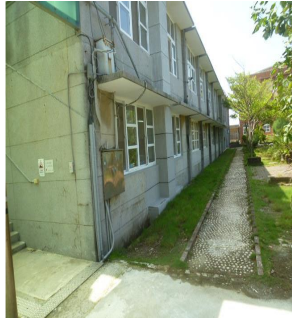
教室の背面にある柱は被覆柱により耐震補強しています。（写真左）窓枠は木製のものから、強化ガラスとプラスチック製窓枠に取り換えています。（写真右）©台湾赤十字組織
