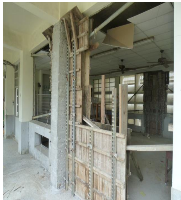
袖壁建築方法により耐震補強中の教室
