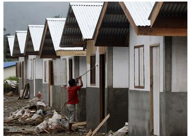
（写真上）コンポステラ・バレー郡の仮設住宅サイト。建設の仕上げを行う© IFRC
