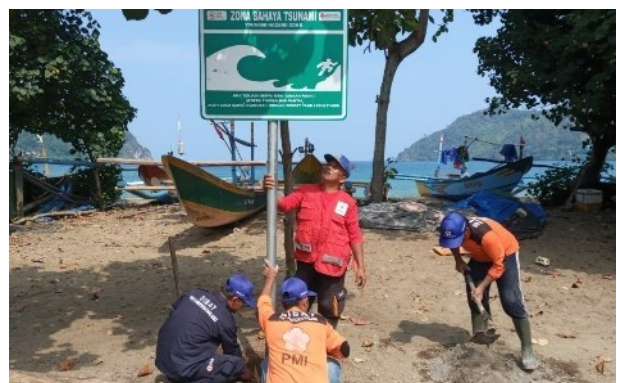
危険スポット、避難経路の標識を設置する様子
