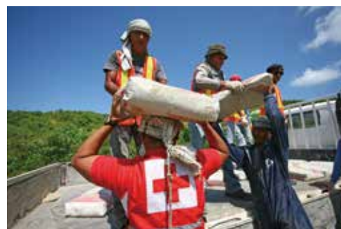
▲被災者と協力して仮設住宅建設の資材運び（フィリピン） © 日本赤十字社
