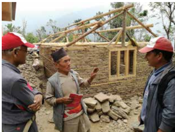
▲自宅を再建する被災者（中央）と進捗確認に訪れたネパール赤十字社と日赤職員。日赤は住宅再建支援の一環として、1,845世帯を対象に約30万円の補助金の支給と再建の技術モニタリングを行っています。2018年7月末現在、約1,500世帯が再建工事をはじめ、650以上の世帯が新居を完成させています。 © 日本赤十字社
