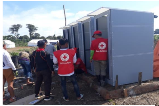
被災者が避難するキャンプに赤十字ボランティアたちが簡易トイレを設置@ラオス赤十字社
