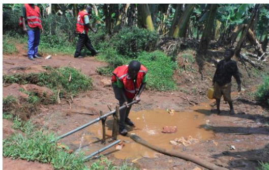
水道管の不具合をなおすルワンダ赤のボランティア
