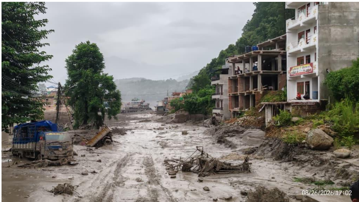
洪水により住宅やインフラに深刻な被害が生じたヌワコット郡©NRCS
