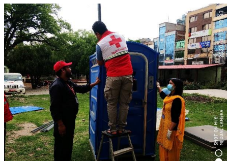
隔離施設で簡易トイレを設置するネパール赤十字社スタッフ©NRCS
