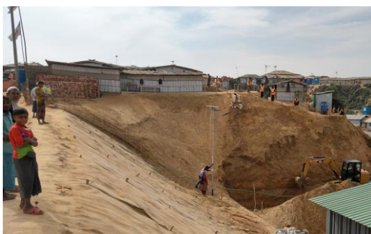
ヘルスセンターの崖工事の様子
