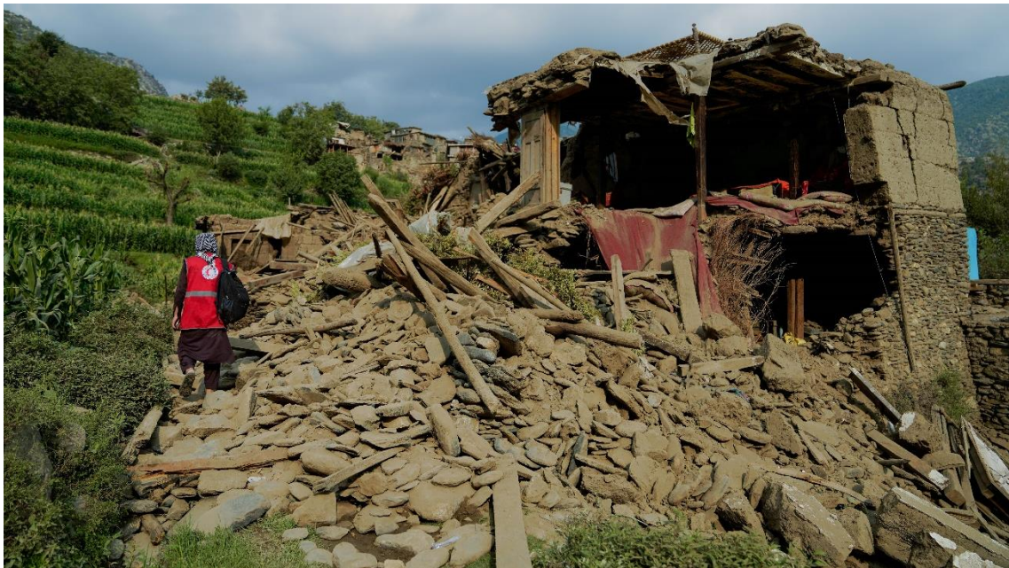
地震により倒壊した建物（2025 年 9 月 1 日撮影）。アフガニスタン赤新月社は発災直後から被災地で被害状況調査や救援活動を実施。©IFRC
