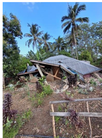
地震により倒壊した建物©インドネシア赤十字社
