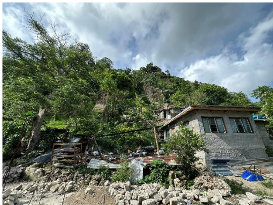
コミュニティを襲った土砂崩れ©IFRC
