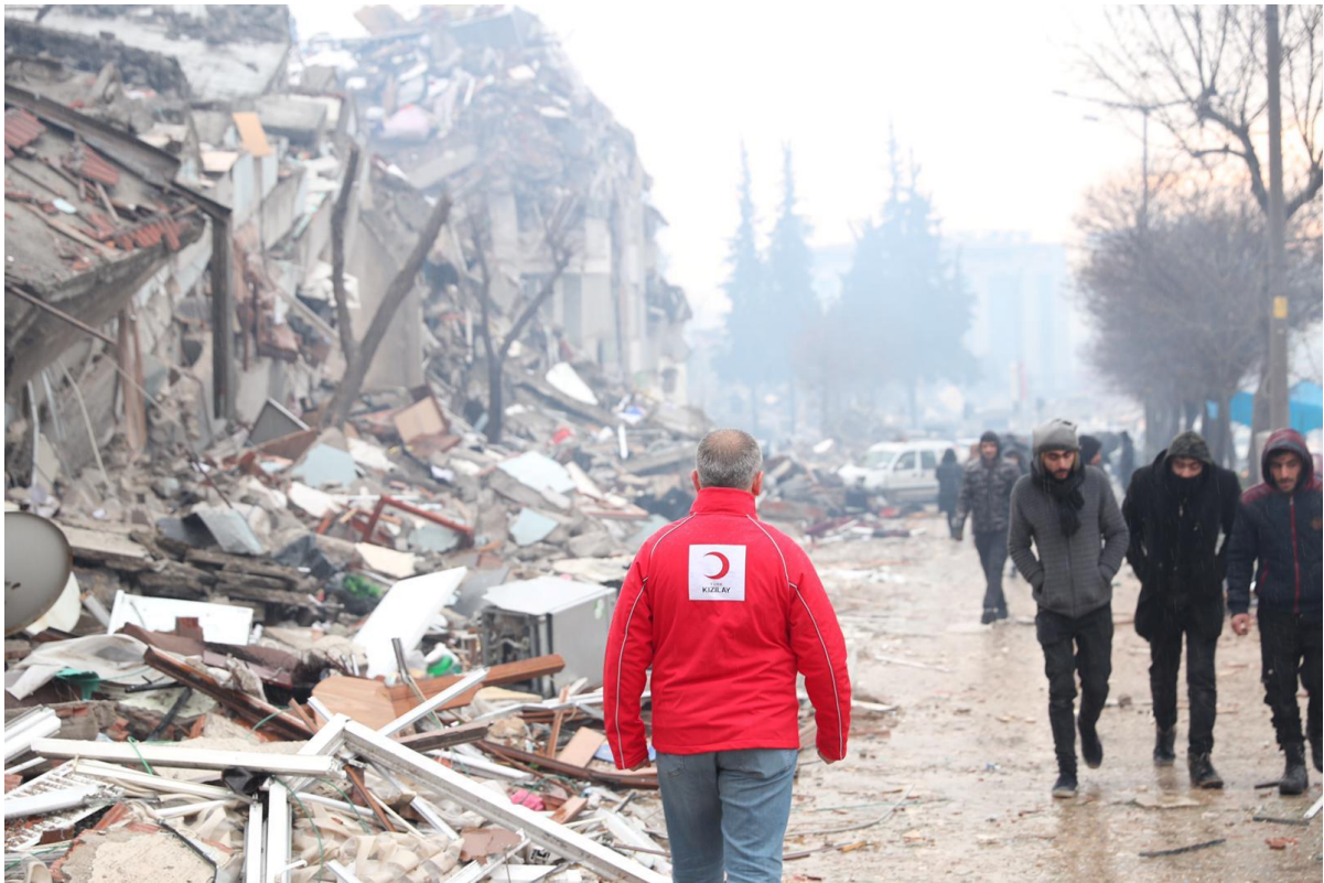
多くの建物が倒壊し、壊滅的な被害を受けている被災地(トルコ)©TRCS
