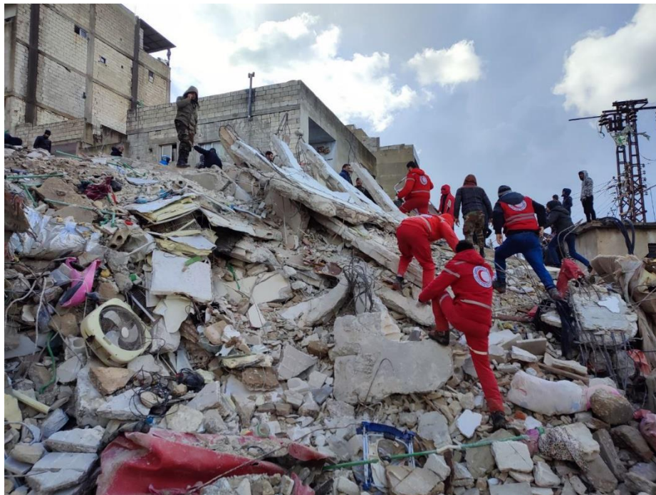
崩壊したビルの現場で救護活動にあたるシリア赤新月社のスタッフ ©SARC
