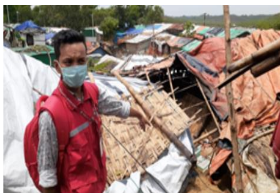
（左写真）キャンプ 13 にて家屋損壊の様子。竹とビニールの簡素な家は被害を受けやすい ©バングラデシュ赤新月社
