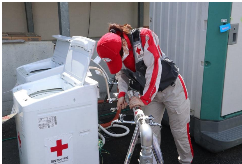
給水器材と洗濯機を設置する熊本赤十字病院の職員（熊本県 八代市）
