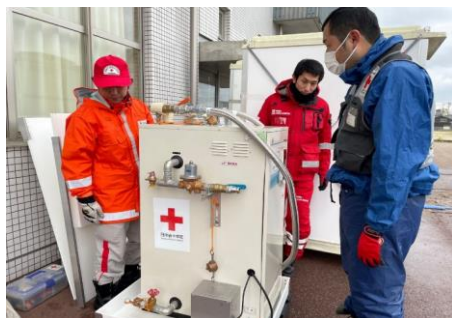
「給水支援の資機材を設置する日赤職員(石川県七尾市)」
