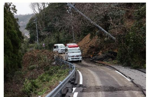
土砂崩れの脇を通る救護班©渋谷敦志
