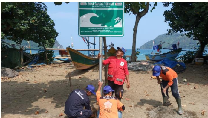
津波の標識を設置する村落防災ボランティア
