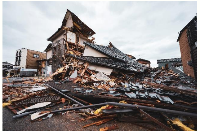
令和6年能登半島地震で倒壊した家屋
