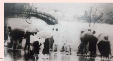
流出寸前の錦帯橋の様子 山口県立山口図書館所蔵 書名：錦帯橋 平成の架替 著者名：金田 惺 出版社：ヨハネハウス・ヨハネ建設
