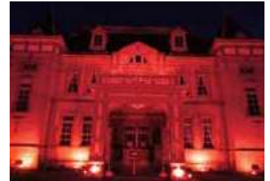
旧米沢高等工業学校本館(米沢市)
