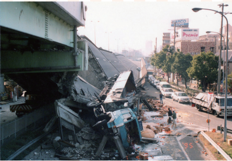
阪神・淡路大震災での高速道路倒壊被害 写真提供：神戸市
