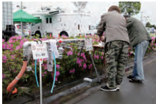
熊本地震の際、避難所に設置された手洗い場
