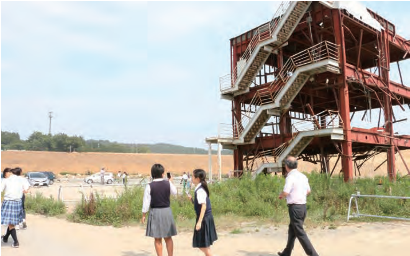
宮城県南三陸町の旧防災対策庁舎は建物を大きく上回る津波に襲われ骨組みだけが残った。部員たちは自分がこの場にいたらどうしたか、自ら考え東京に戻った。
