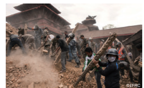
発災直後の街の様子。歴史的建造物も多く崩壊した
