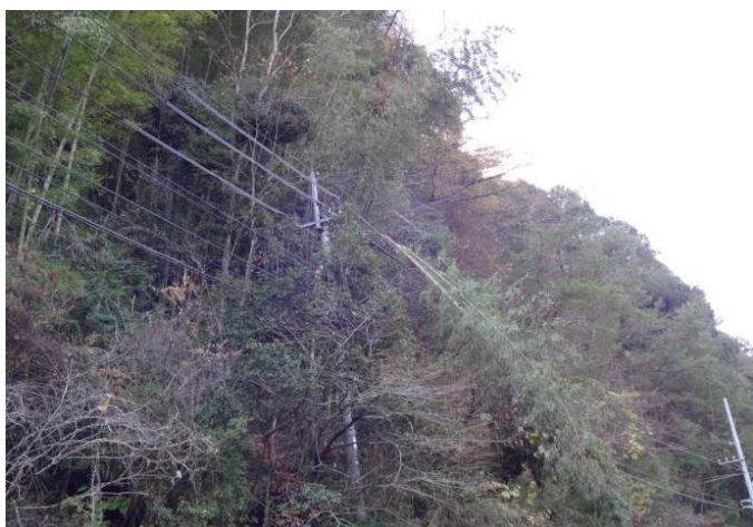
停電の原因となった倒木の様子
