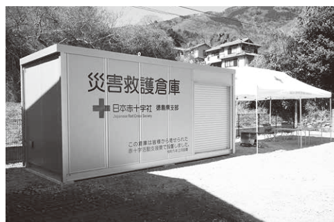
三好市池田町に新たに設置した西部災害救護倉庫
