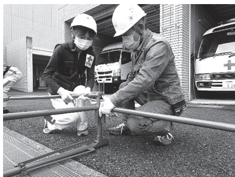
【パイプテントの設営を体験する参加者】
