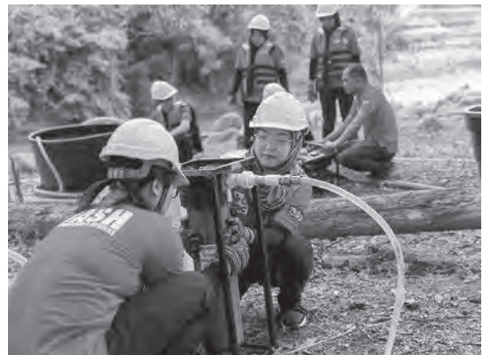
▲緊急給水衛生研修で浄水機器を設置する参加者（マレーシア）
