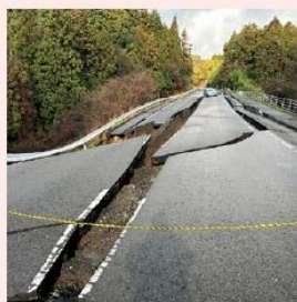
地割れで崩落した道路 迂回を余儀なくされる
