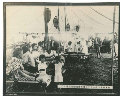
皇居前広場救護所大テントの活動状況 (関東大震災当時)
