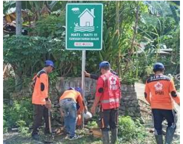
洪水発生注意の表示を設置する様子 （インドネシア・コミュニティ防災強化事業）
