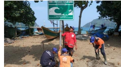
資金支援による津波注意の看板設置 (インドネシア)
