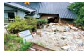
基山町の被災状況
