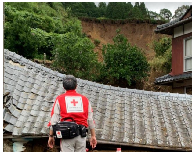
「嬉野市嬉野町大舟地区の土砂崩れの様子」
