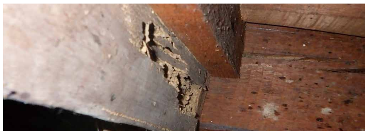
シロアリによる被害が見受けられた箇所
