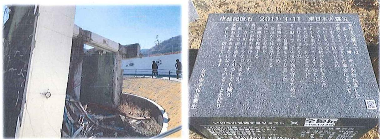
震災遺構である、旧女川交番を訪れた。旧女川交番は鉄筋コンクリートで作られていたが、津波の引き波で杭が抜け横倒しになったとされている。鉄筋コンクリートの建物が横倒しになる例は世界的にも珍しく、それだけ津波の大きさ、引き波の強さを表している。「津波記憶石」被災地各地に建てられ、は単に津波の高さだけを記すのではなく、この被害を忘れないためにという思いも込められている。
