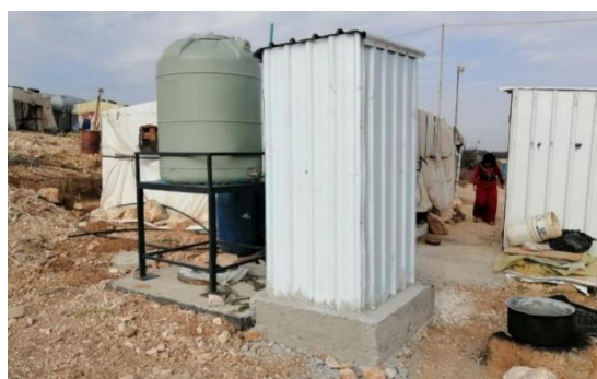
世帯ごとに設置した給水タンクとトイレ設備
