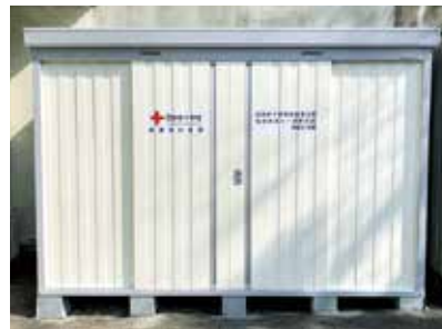
赤十字救護資材倉庫
