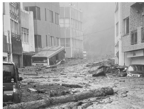
(令和 3 年 7 月 1 日からの大雨：熱海市)
