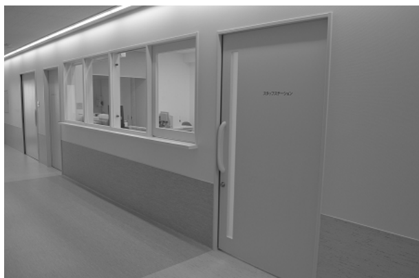
(施錠が可能なスタッフステーション)
