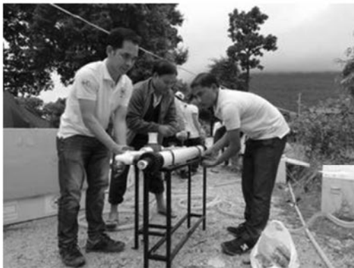
(浄水ユニットの設営)
