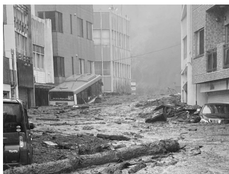
(令和3年7月1日からの大雨：熱海市)
