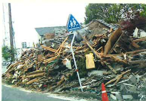
倒壊した家屋（益城町）
