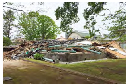
熊本地震で崩壊したジェーンズ邸
