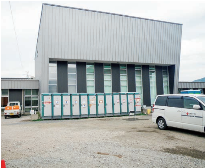
益城町総合体育館敷地内の避難者用トイレ
