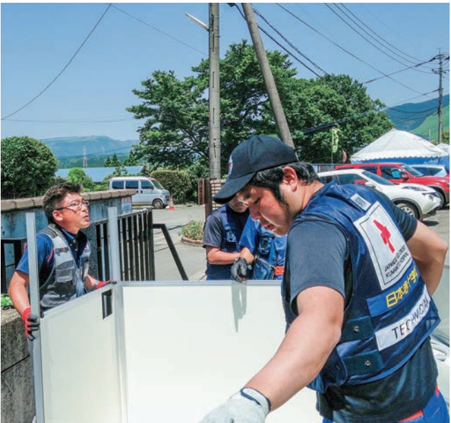
更衣室用コンテナを組み立てる職員
