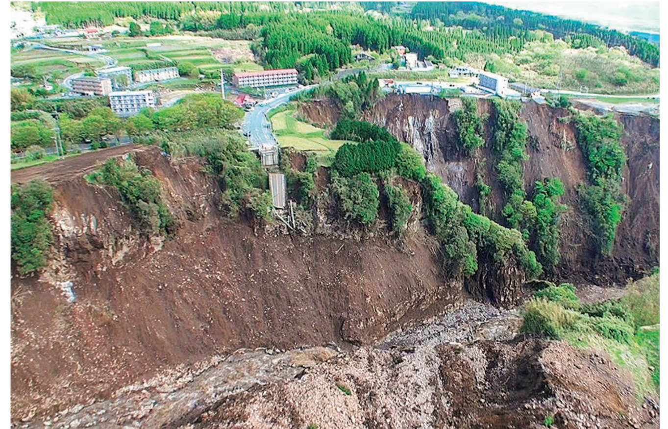
崩落した阿蘇大橋
