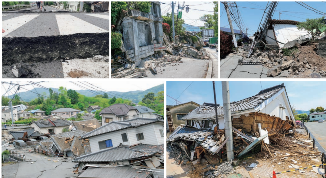
益城町では2階建て家屋の1階部分が損壊した
