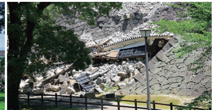
崩落した石垣
