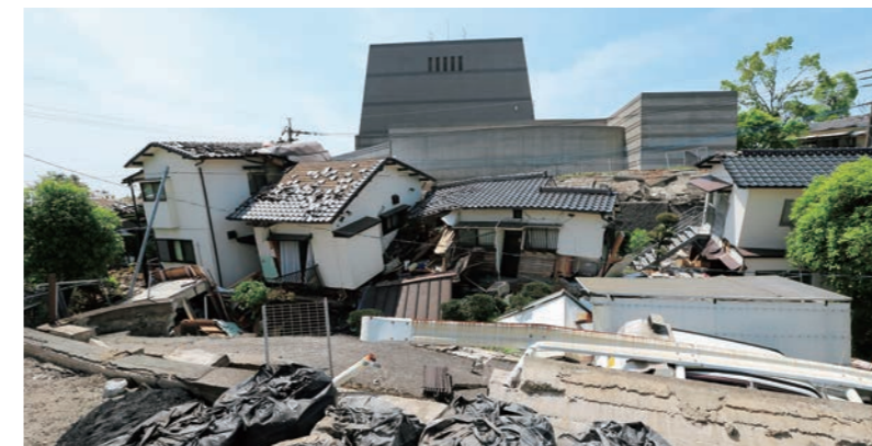
被害を受けた益城町の中心地
