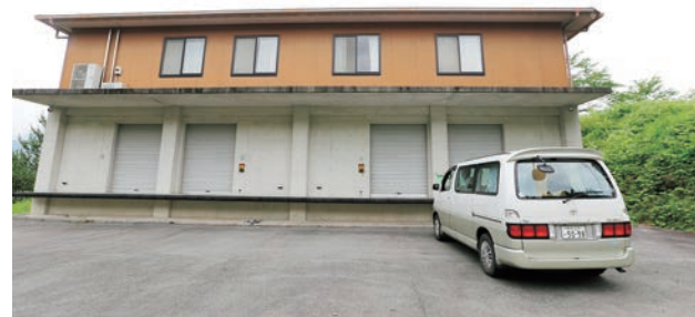
アソシエート同敷地内にある救護員宿舎及び救護資機材倉庫
