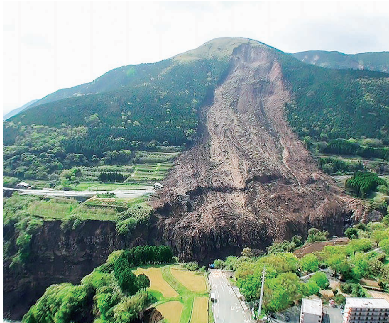
阿蘇大橋があった山腹崩落現場
