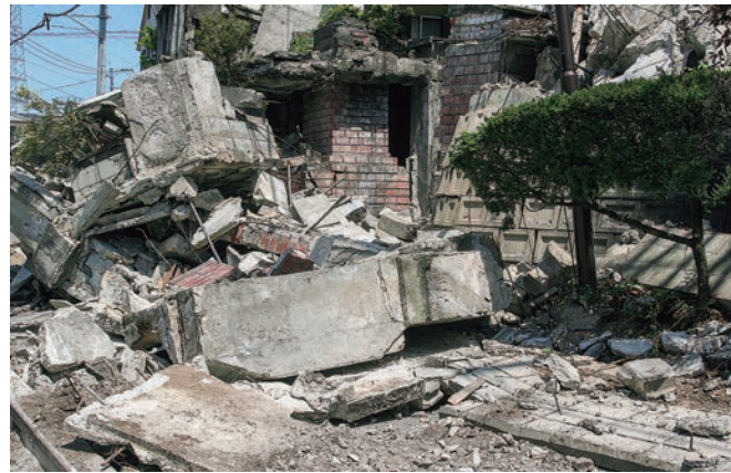
被災宅地の被害写真
