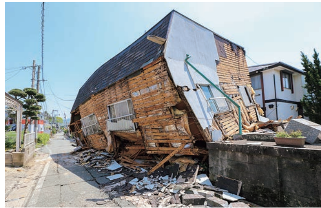
激震により倒壊した家屋
