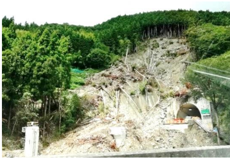
①(大豊町)高知自動車道の立川トンネル付近の土砂崩れにより一部道路が崩落した様子。これにより、一時上り線の通行が不可となっていました。現在は下り線2車線を片側車線通行できるようにしています。
