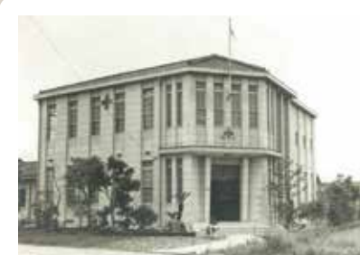
鹿児島市郡元に鹿児島支部新庁舎完成
